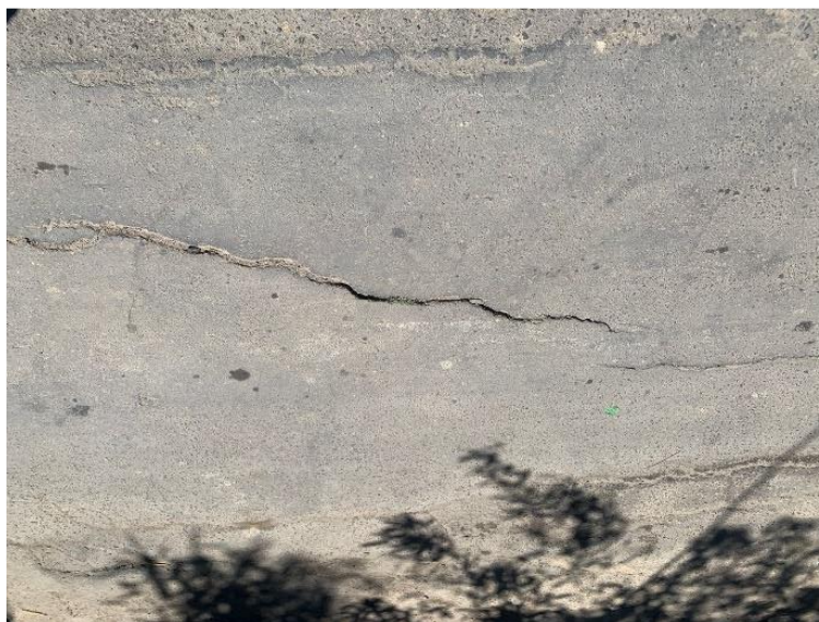
FOTO 6: Trinca no pavimento indicando movimentação do solo
