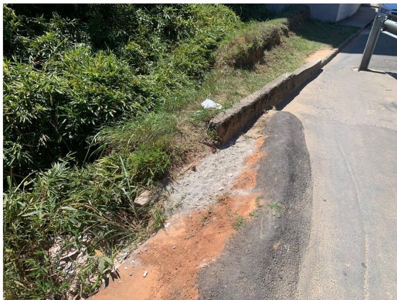
FOTO 4: Vista do talude onde foi construída leira de proteção.
