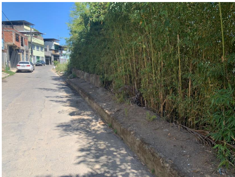
FOTO 5: Ao longo deste trecho há uma contenção em trilhos que poderá ser aproveitada na construção da cortina.
